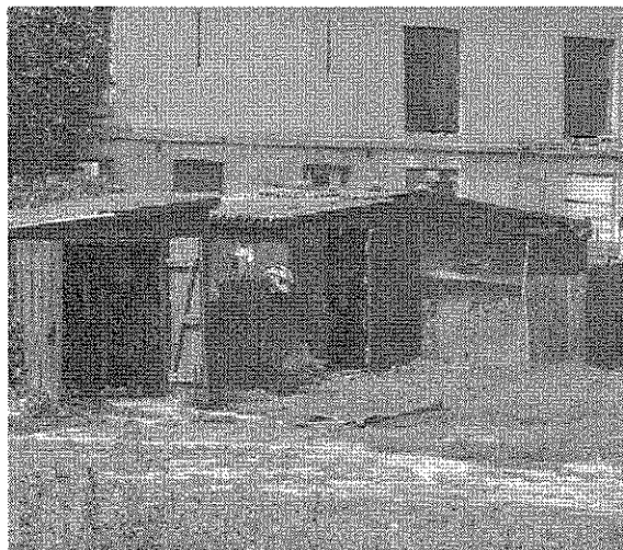
Fot. 9 i 10. Pokrycie używanym „eternitem” szop w miejscowościach Orzeszkowo i Bagowie.
