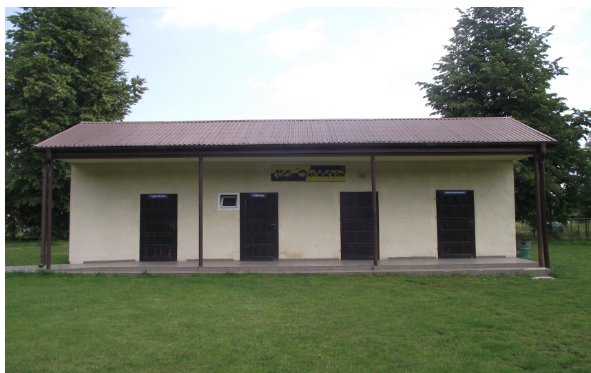
Rys. 2: Widok obecnego stanu elewacji zachodniej
