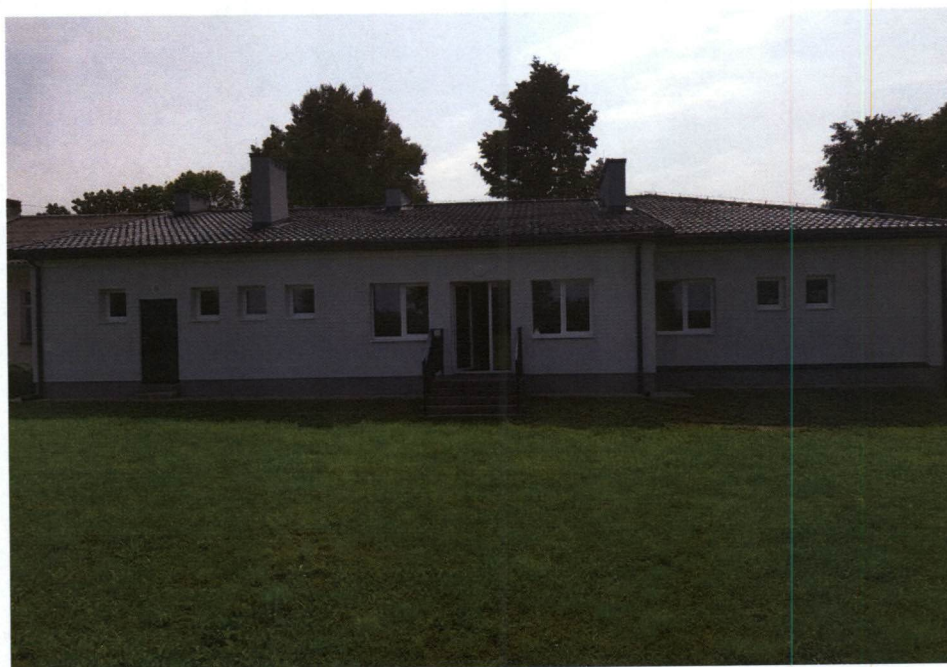
„Przebudowa (modernizacja) mająca na celu przystosowanie budynku na świetlicę wiejską we wsi Budzyno, gmina Czerwonka”
