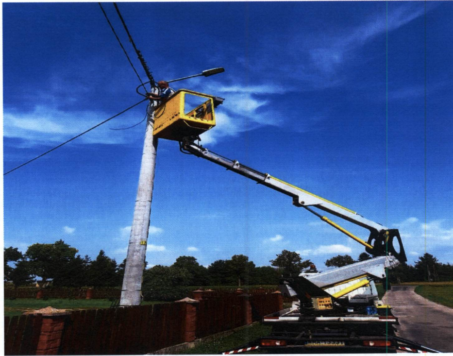
„Budowa oświetlenia ulicznego na terenie gminy Czerwonka”
