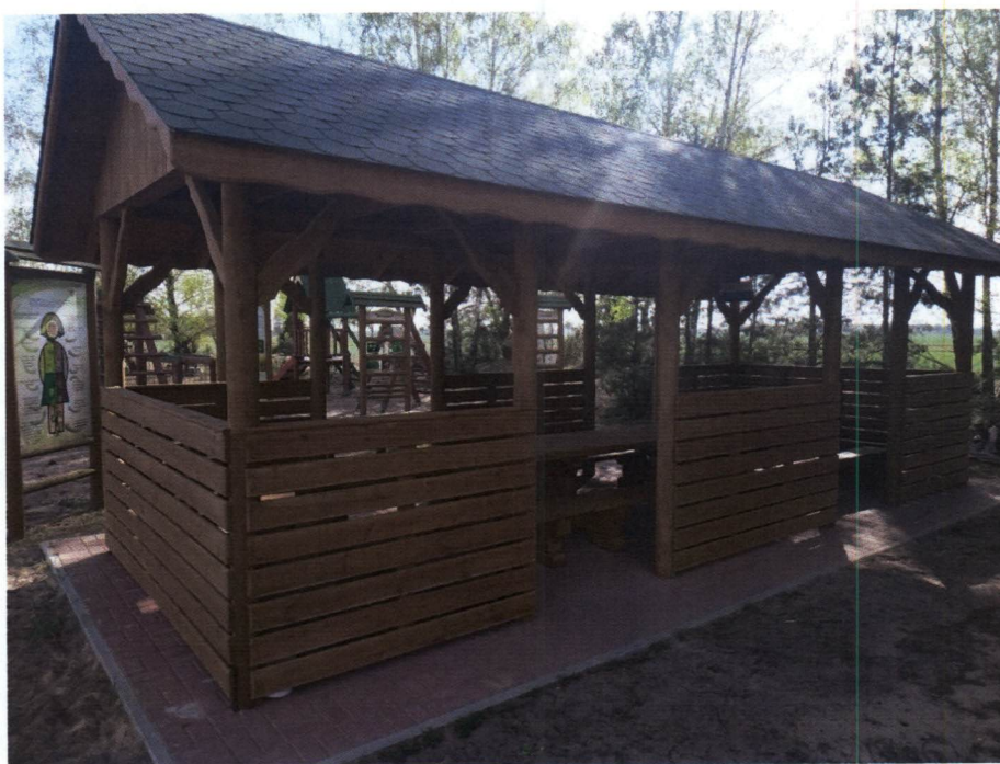
„Wykonanie altany drewnianej w miejscowości Lipniki”
