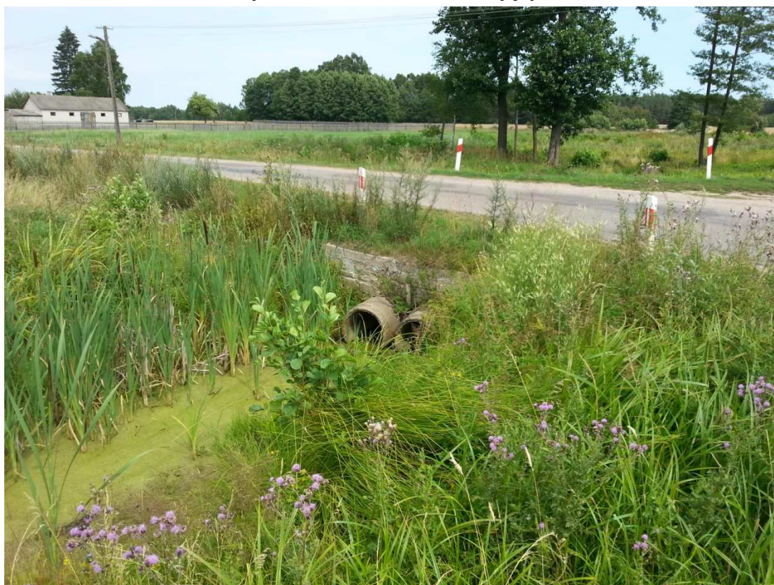
Rys. 2. Wlot rowu R-A-2 do zbiornika.
