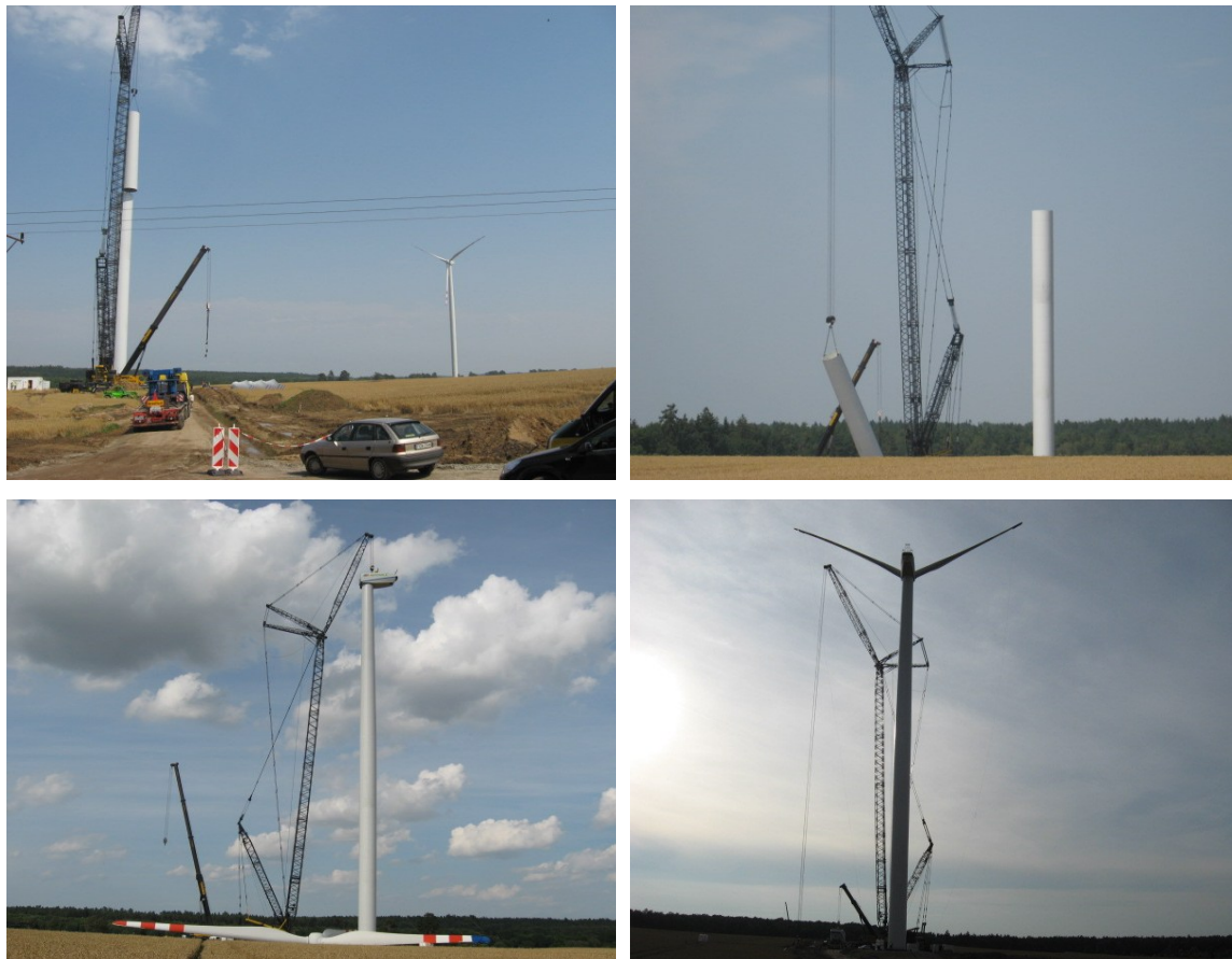
Rycina 15. Etapy budowy przykładowej elektrowni wiatrowej
