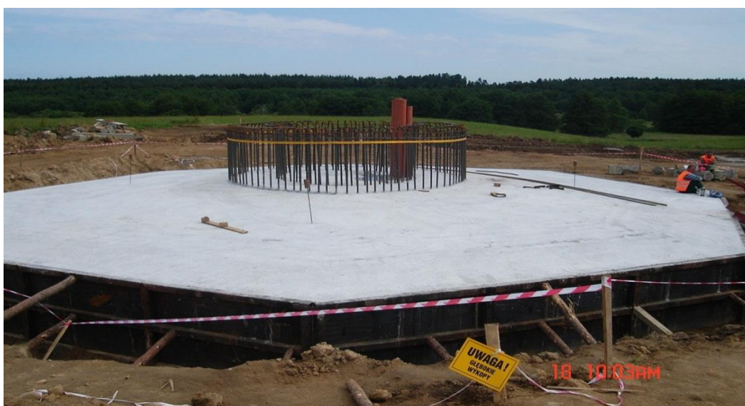
Rycina 3. Budowa fundamentu (przykład nie dotyczy realizowanej instalacji)
