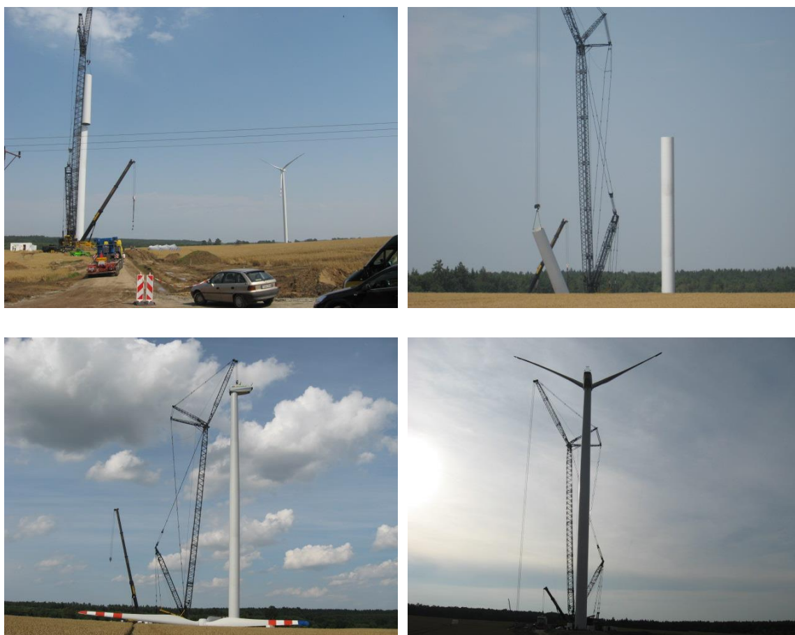
Rycina 5. Etapy budowy przykładowej elektrowni wiatrowej
