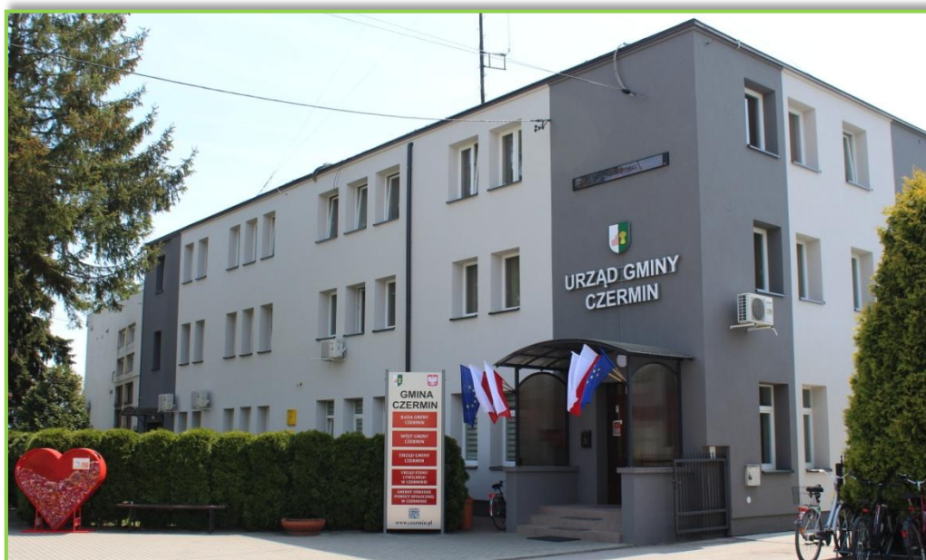
Zdjęcie 6. Nowa elewacja budynku Urzędu Gminy Czermin
