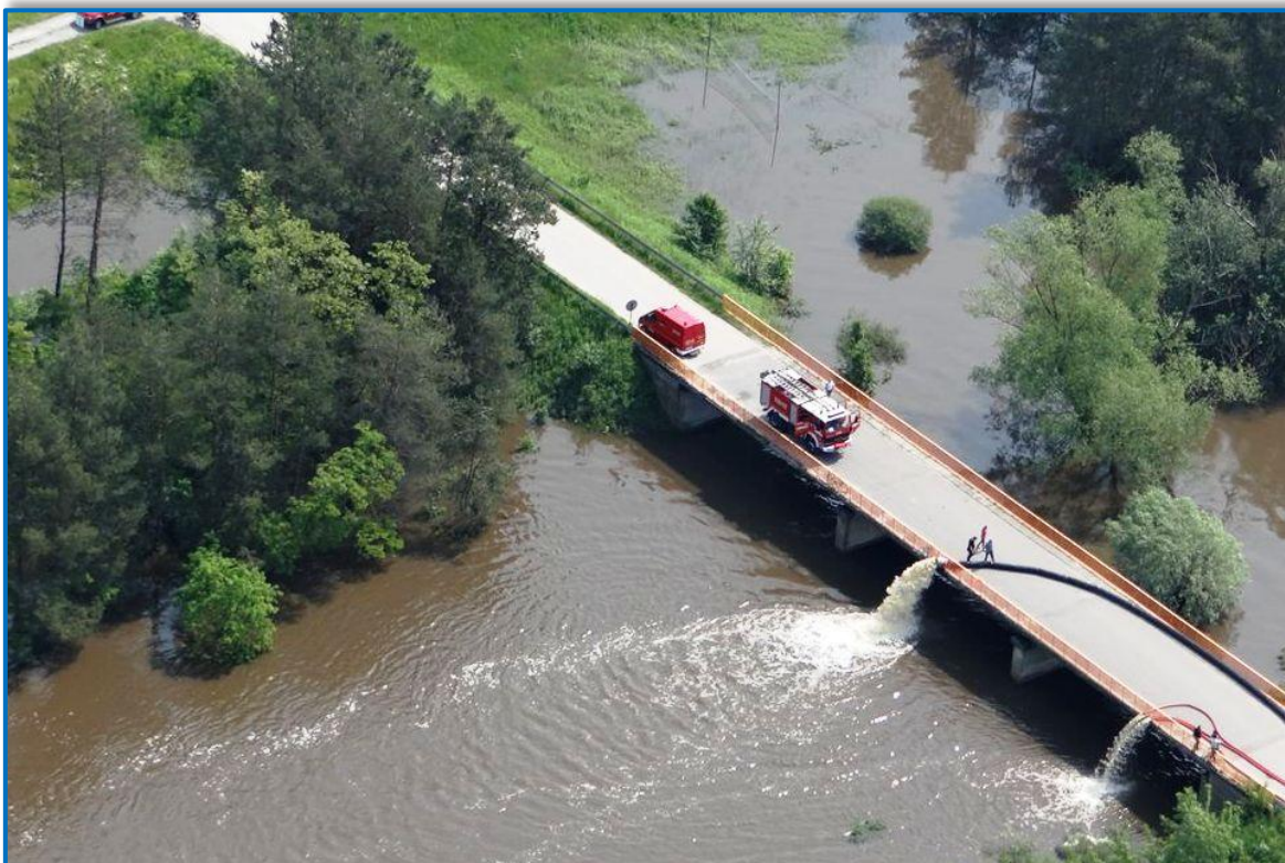
Zdjęcie 3. Pompowanie wody z zalanych terenów Ziempniowa do koryta rzeki Nowy Breń (25 maja 2019 r.)
