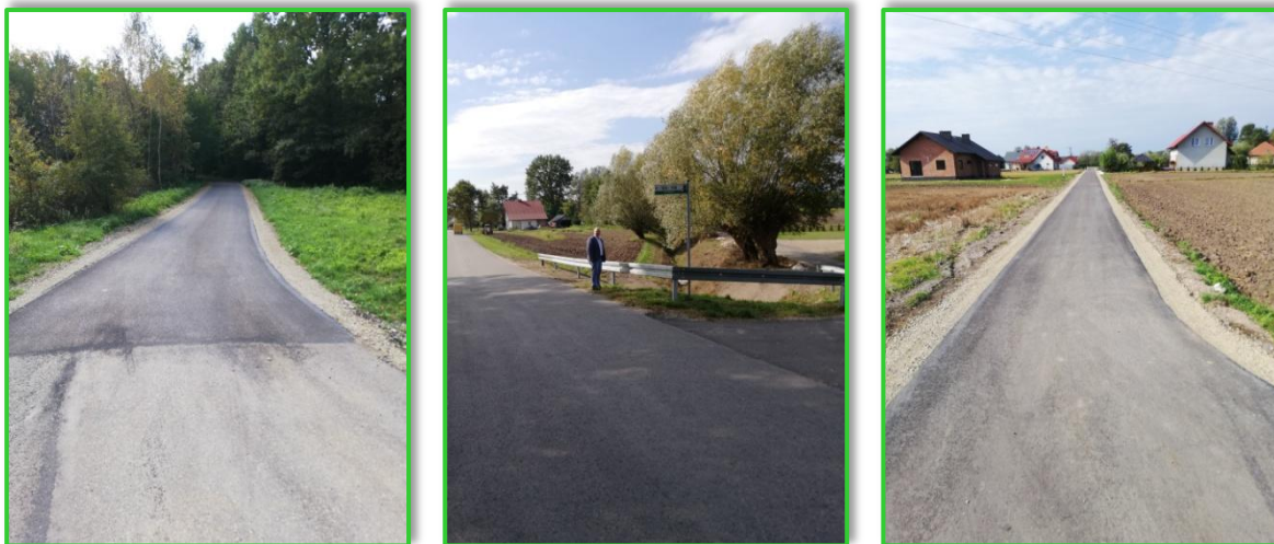
Zdjęcia 6-8. Nowe nawierzchnie dróg wewnętrznych (wrzesień 2019 r.)
