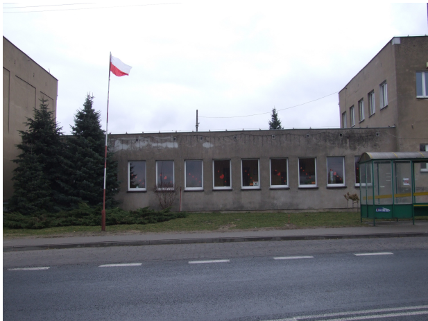
Foto.9 Łącznik od zachodu (ulicy)
