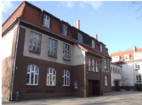
Foto.2 Budynek starej szkoły od dziedzińca wew.
