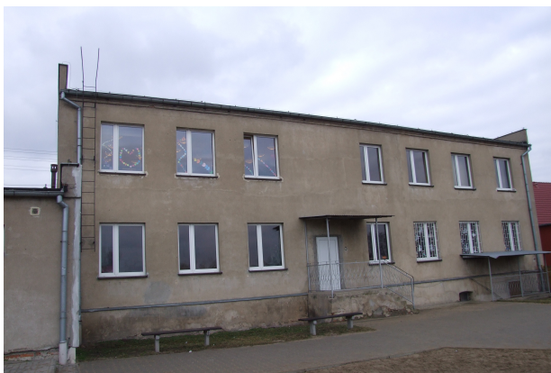
Foto.11 Budynek północny od strony boiska
