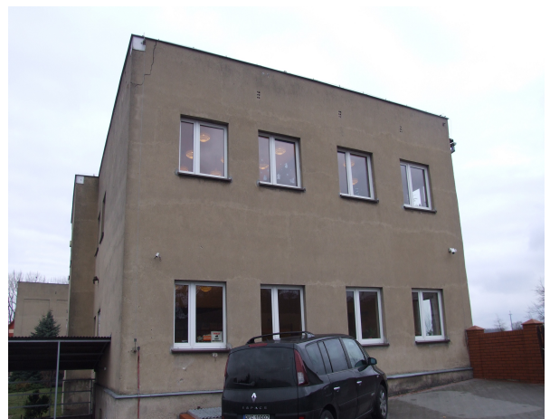
Foto 10 Elewacja południowa od parkingu
