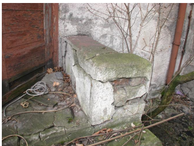
Fot. 29 – Szczegóły uszkodzeń schodów zewnętrznych widocznych na fot. 28. Z lewej widoczne zniszczone stopnie, z prawej murki balustrad. Ponadto uwagę zwraca zły stan techniczny drewnianej stolarki drzwiowej.
