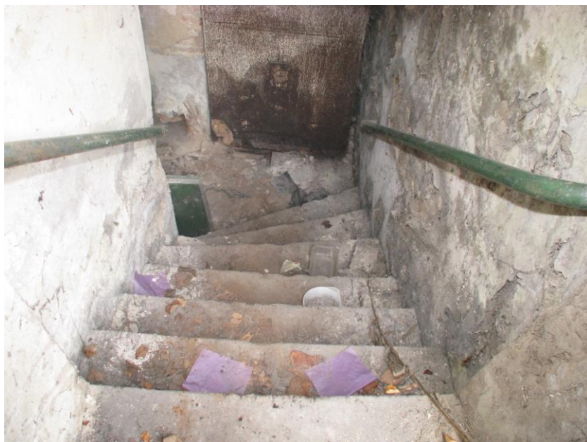
Fot. 30 – Schody zejściowe do piwnicy – stan techniczny zadowalający. Uwagę zwracają zdewastowane i zawilgocone tynki ścienne – porównaj z fot. 17.
