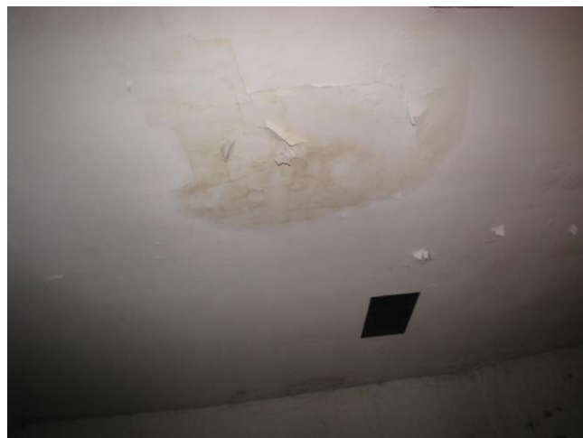
Fot. 25 – Zawilgocenia tynku na suficie podwieszonym w sali kinowej świadczące o nieszczelnościach w pokryciu dachowym budynku
