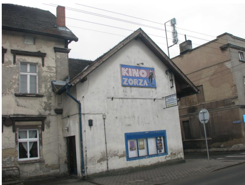
Fot. 3 – Widok elewacji szczytowej (północnej) od strony ul. 24 Stycznia – z lewej widoczne wejście główne do budynku (dawnego kina).
