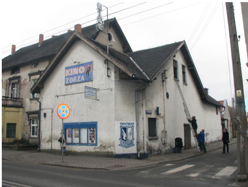
Fot. 1 – Widok elewacji frontowej budynku od strony naroża północno-zachodniego (zbiegu ulic 24 Stycznia i Strumykowej).
