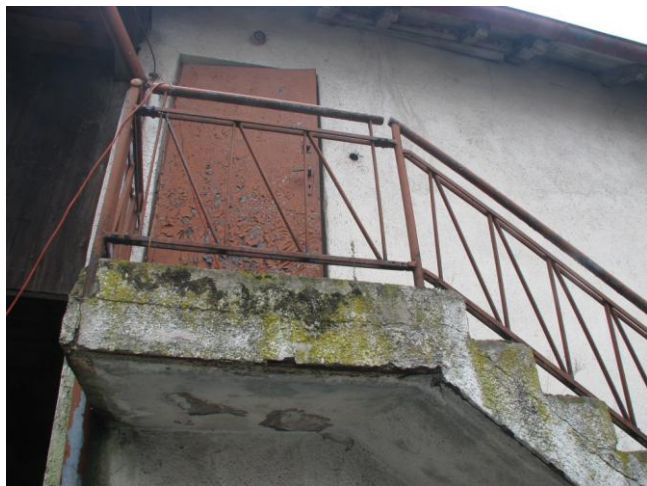
Fot. 27 – Uszkodzenia betonowych schodów zewnętrznych prowadzących do projektorowni. Widoczne spękania i korozja biologiczna betonu.
