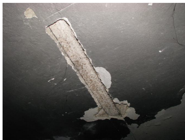
Fot. 23 – Odkrytki konstrukcyjne podciągu stalowego (z lewej) oraz belki stropowej (z prawej) w celu przeprowadzenia pomiarów inwentaryzacyjnych.
