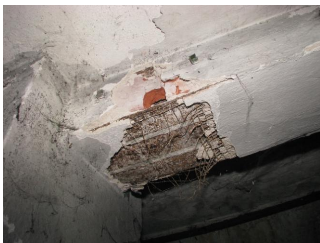
Fot. 23 – Odkrytki konstrukcyjne podciągu stalowego (z lewej) oraz belki stropowej (z prawej) w celu przeprowadzenia pomiarów inwentaryzacyjnych.
