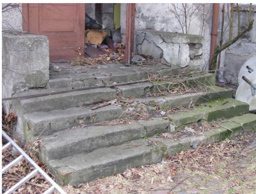
Fot. 27 – Uszkodzenia betonowych schodów zewnętrznych prowadzących do projektorowni. Widoczne spękania i korozja biologiczna betonu.
