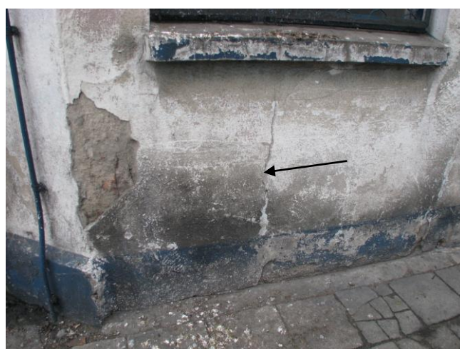
Fot. 14 – Zawilgocenia, zarysowania i odspojenia tynku ściany pod oknem w narożu budynku (u zbiegu ulic).
