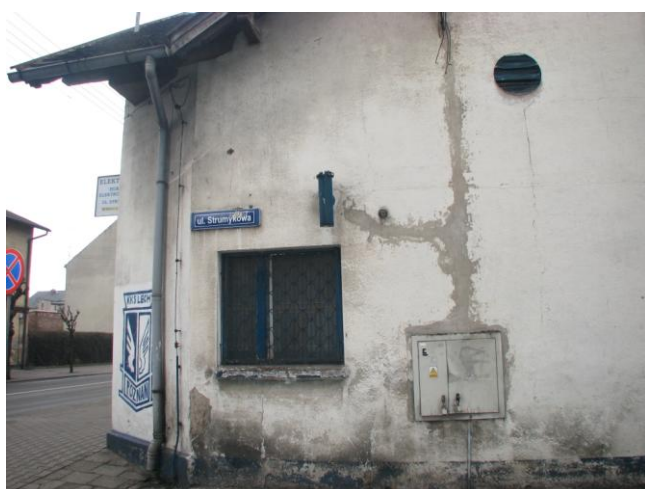
Fot. 14 – Zawilgocenia, zarysowania i odspojenia tynku ściany pod oknem w narożu budynku (u zbiegu ulic).
