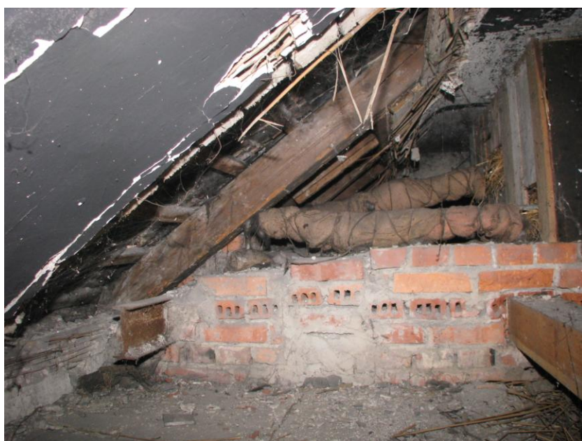
Fot. 8 – Widok fragmentu więźby dachowej budynku w miejscu możliwych oględzin.
