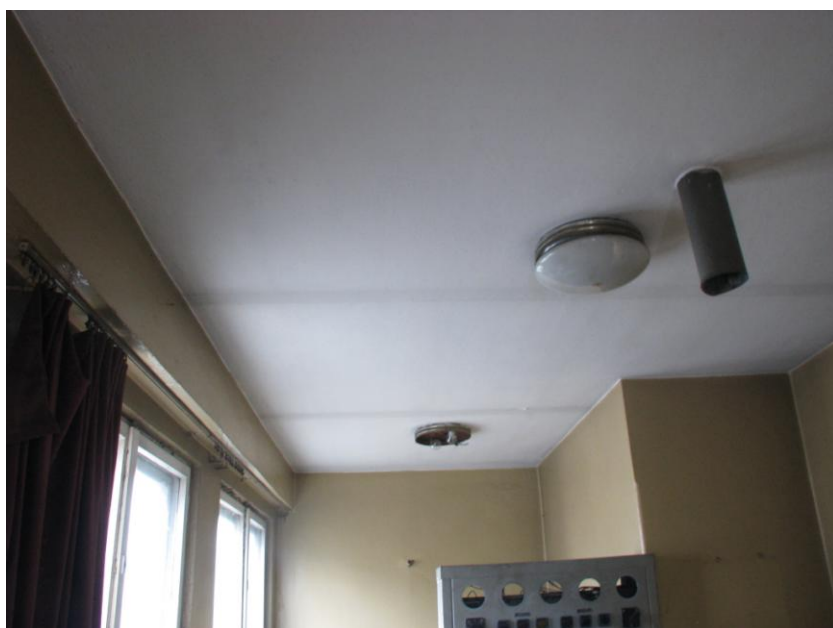
Fot. 25 – Zawilgocenia tynku na suficie podwieszonym w sali kinowej świadczące o nieszczelnościach w pokryciu dachowym budynku
