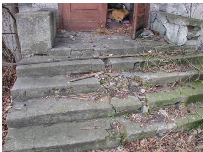
Fot. 29 – Szczegóły uszkodzeń schodów zewnętrznych widocznych na fot. 28. Z lewej widoczne zniszczone stopnie, z prawej murki balustrad. Ponadto uwagę zwraca zły stan techniczny drewnianej stolarki drzwiowej.
