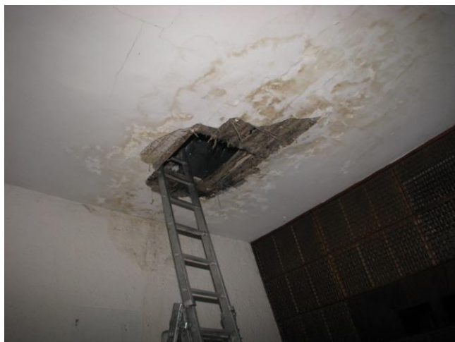
Fot. 25 – Zawilgocenia tynku na suficie podwieszonym w sali kinowej świadczące o nieszczelnościach w pokryciu dachowym budynku
