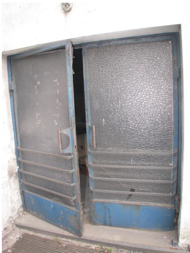
Fot. 31 – Przykład zniszczeń stolarki i ślusarki otworowej – z lewej główne drzwi wejściowe do budynku z prawej okna pomieszczenia na poddaszu (spękane szyby okien poddasza mogą stanowić realne zagrożenie dla użytkowników chodnika – konieczna pilna interwencja ze strony Właściciela obiektu).
