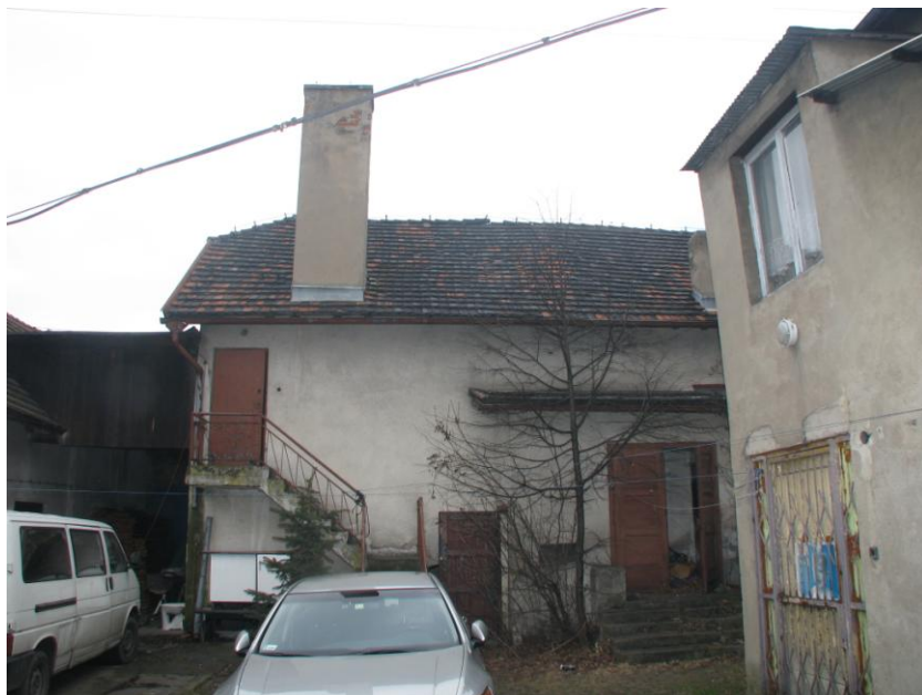
Fot. 4 – Widok elewacji bocznej (wschodniej) budynku od strony podwórza.
