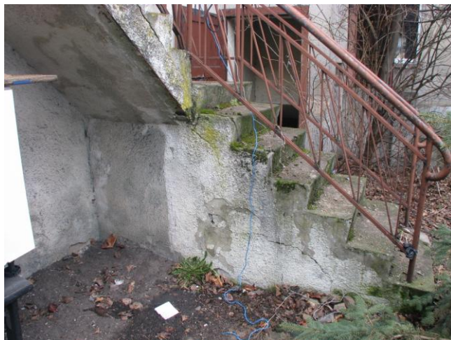
Fot. 27 – Uszkodzenia betonowych schodów zewnętrznych prowadzących do projektorowni. Widoczne spękania i korozja biologiczna betonu.
