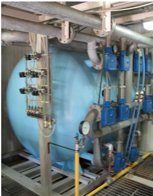
Zdjęcie 4. Filtry ciśnieniowe poziome na SUW Czempień
