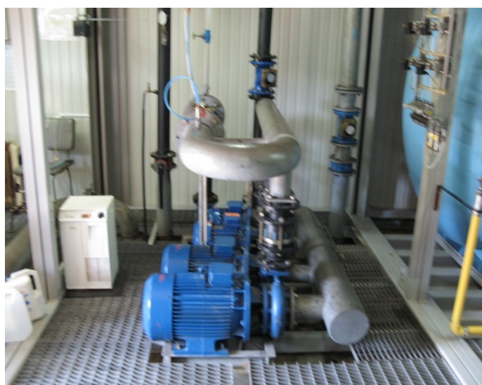
Zdjęcie 6. Zestaw pomp sieciowych na SUW Czempień
