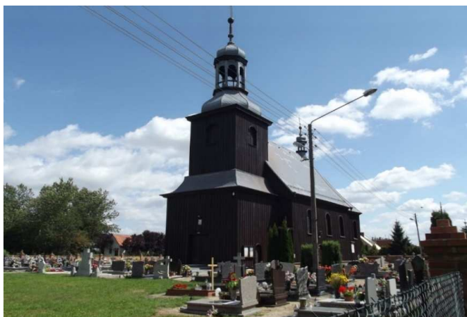
Zdjęcie 7. Kościół p.w. Wniebowzięcia Najświętszej Panny Marii
