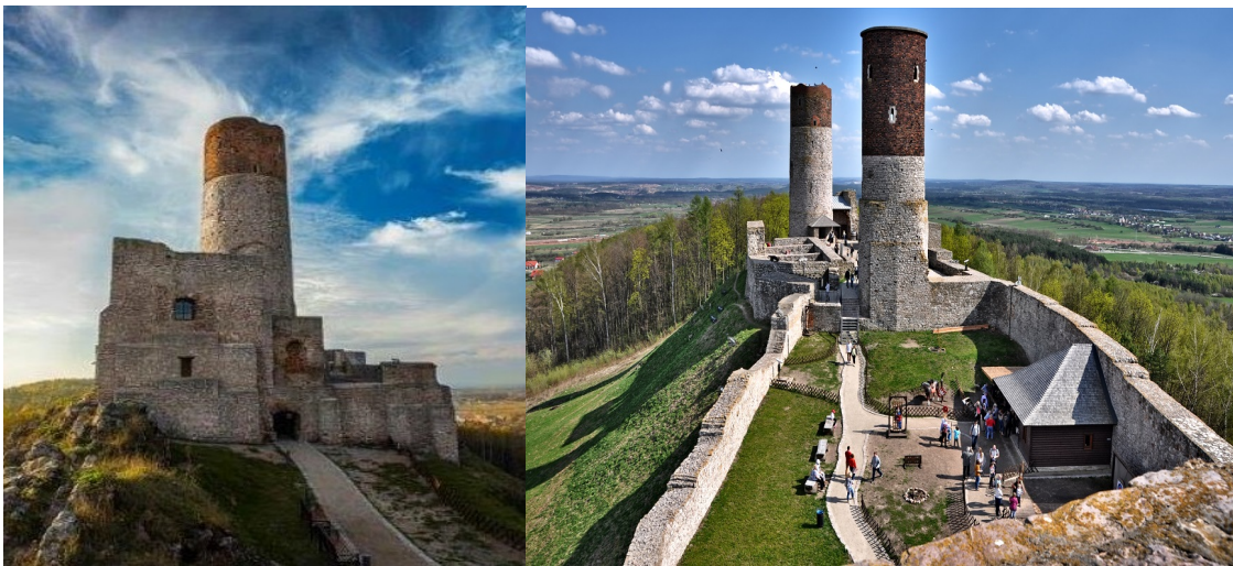
Zamek Królewski w Chęcinach po rewitalizacji
