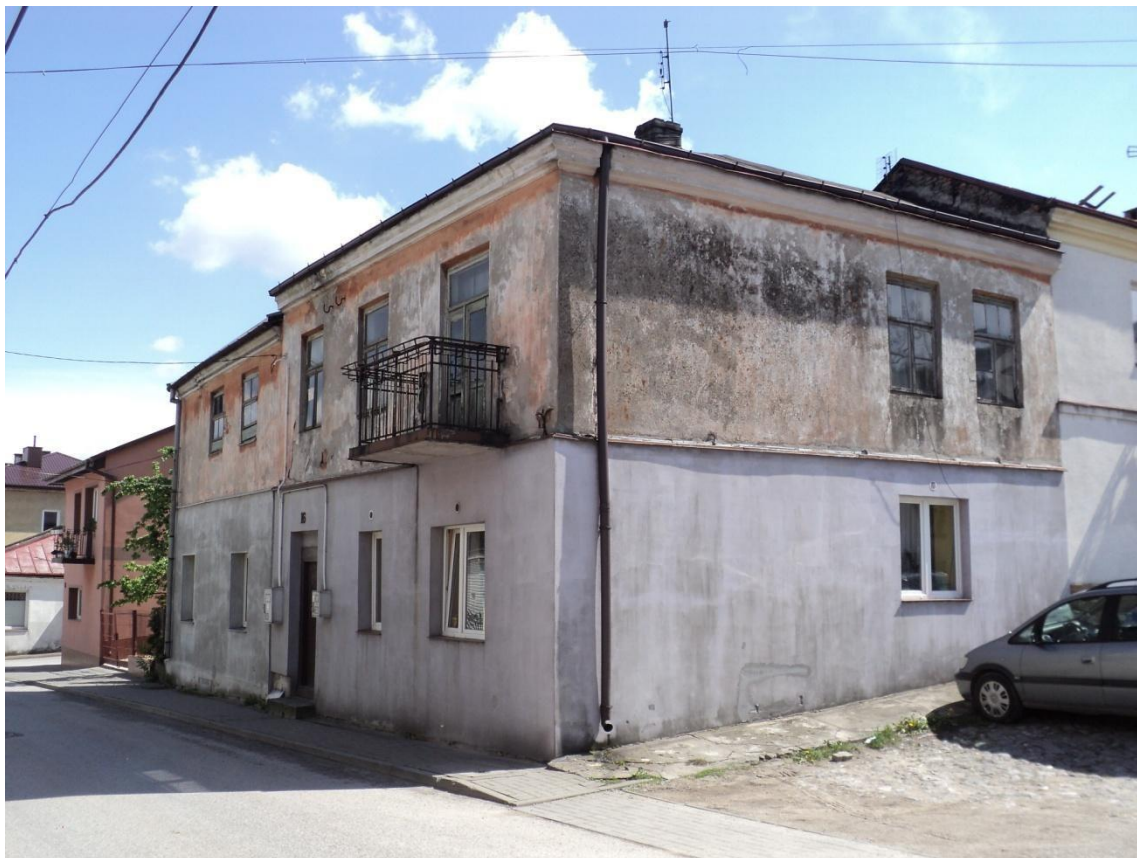
Elewacja od ul. Długiej
