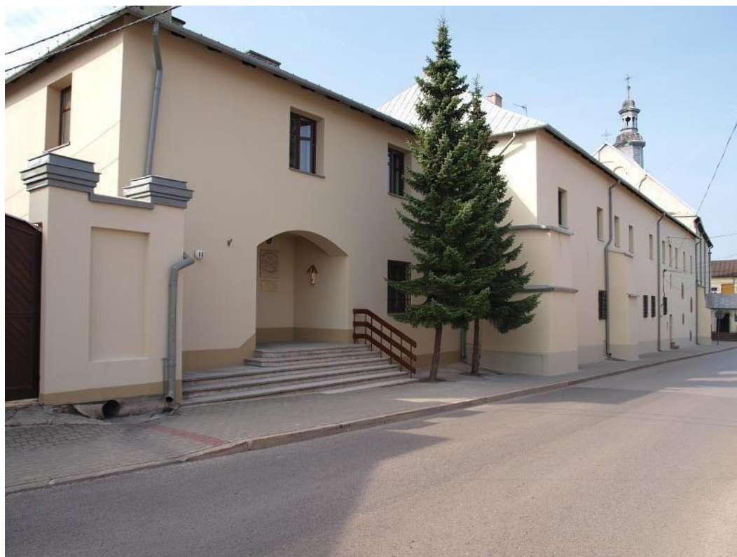
Elewacja od ul. Małogoskiej
