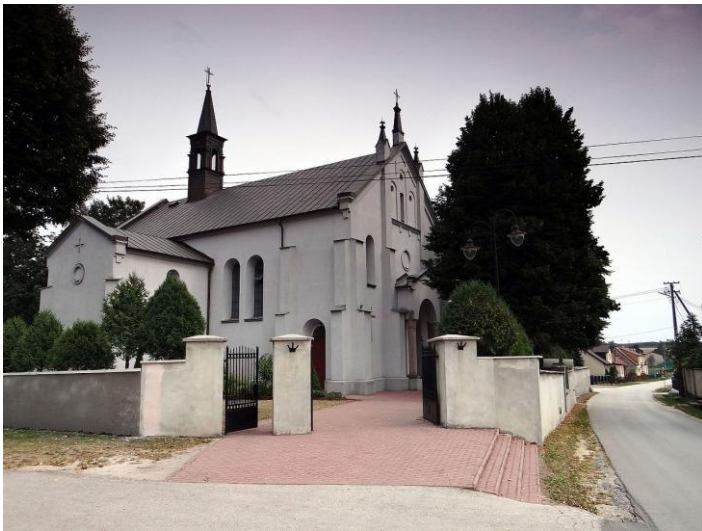
Widok od strony drogi głównej
