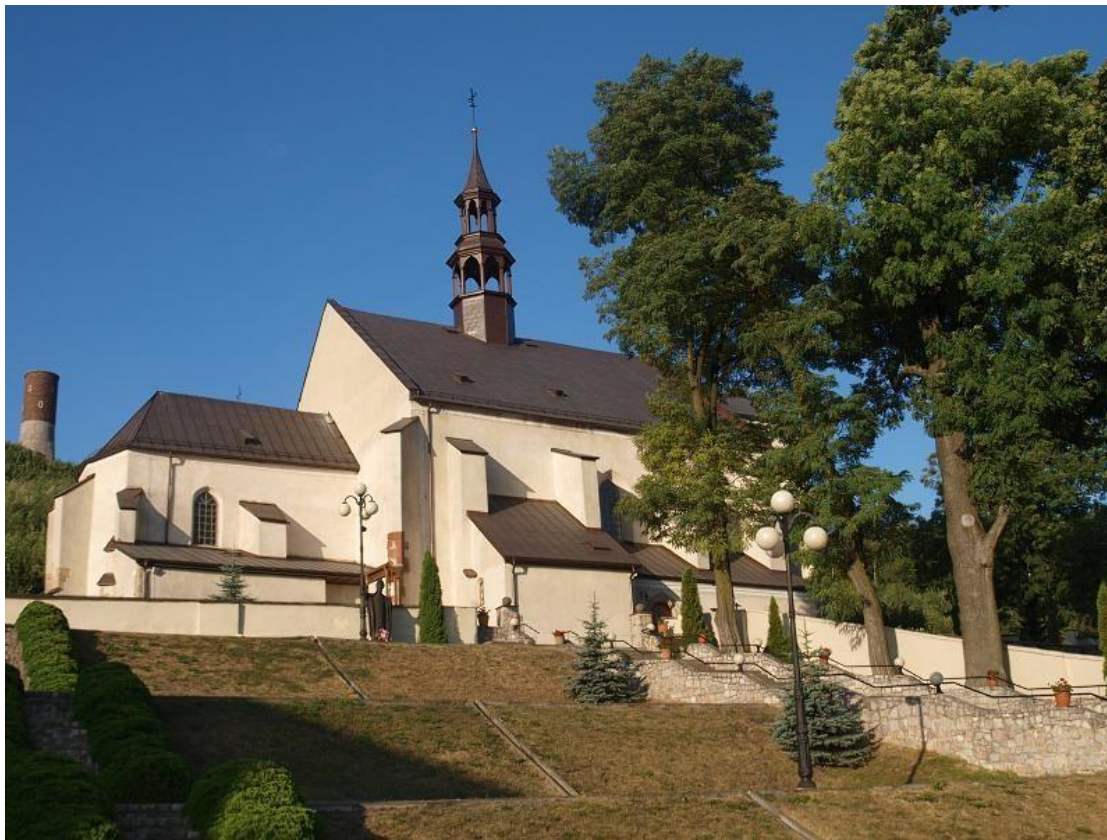
Widok od strony parkingu przy ul. Radkowskiej
