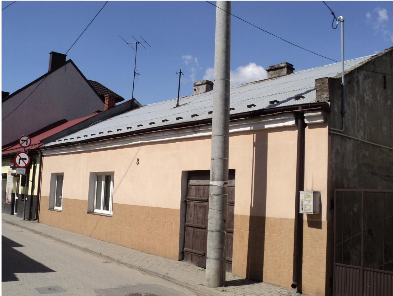
Elewacja płd. od ul. Długiej
