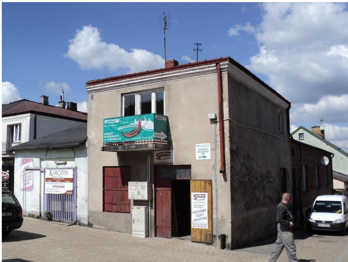
Widok od strony pld.-wsch.
