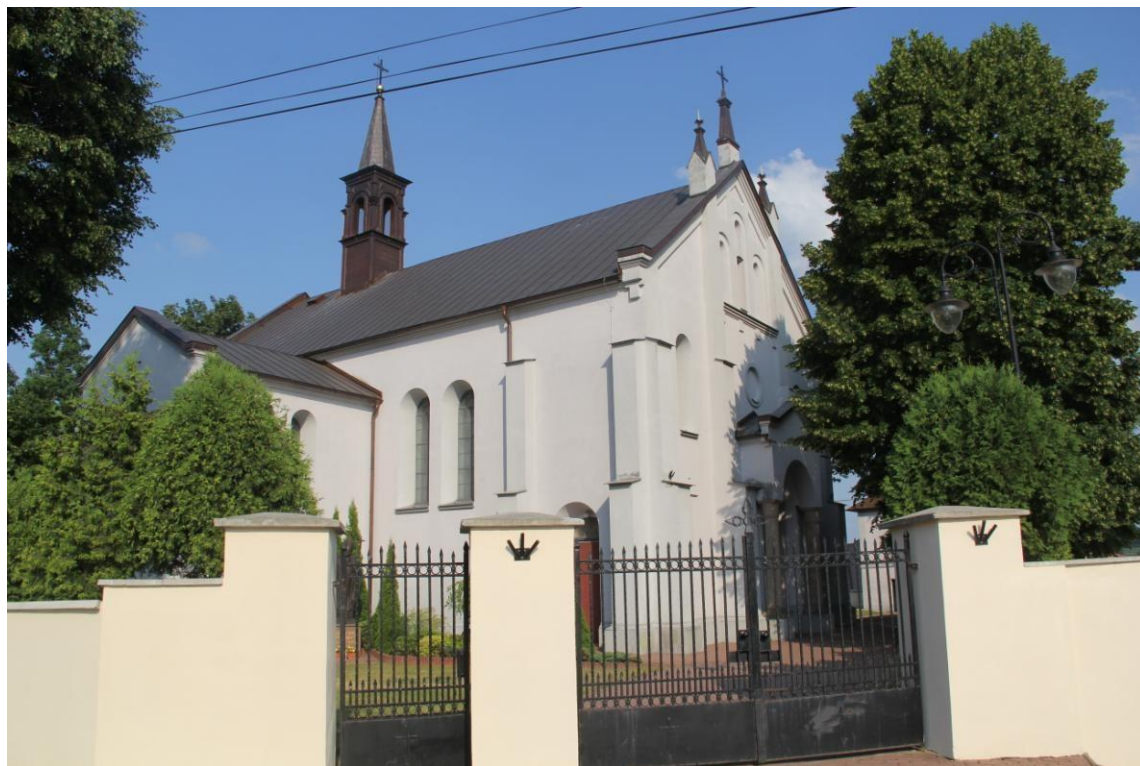
Widok od strony drogi powiatowej
