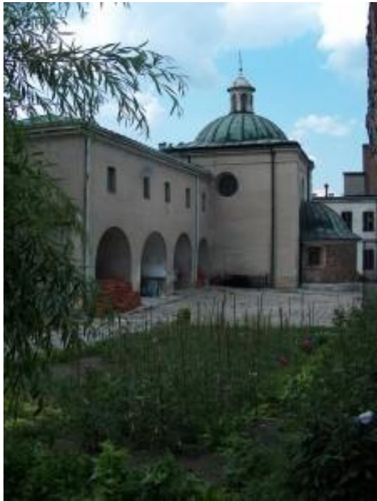
Widok od strony pld.
