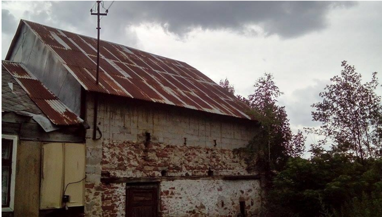
Widok od strony płd., drogi powiatowej
