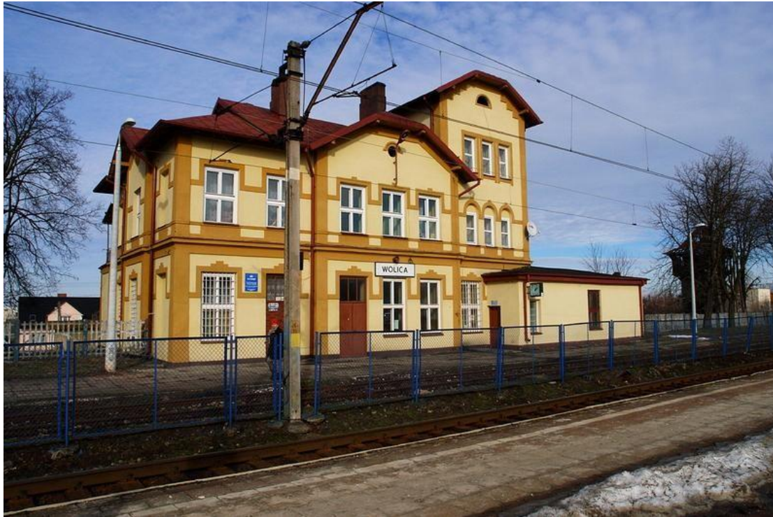
Elewacja od strony płn./peronów
