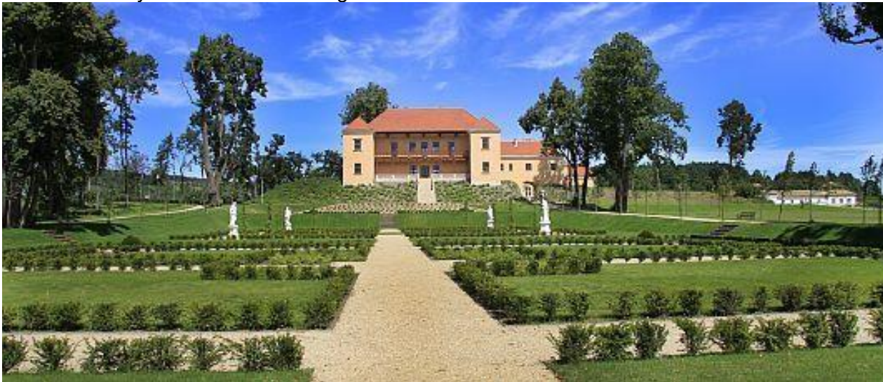
Widok od strony pld.
