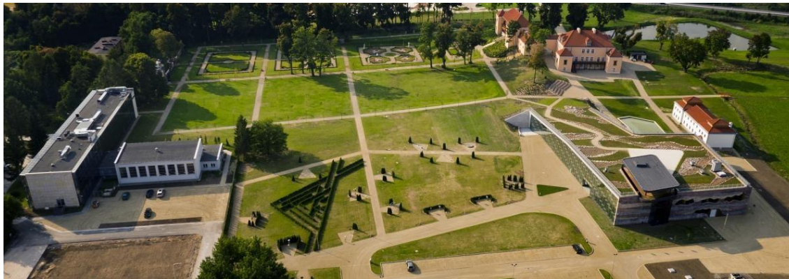
Widok z góry na całość obiektu
