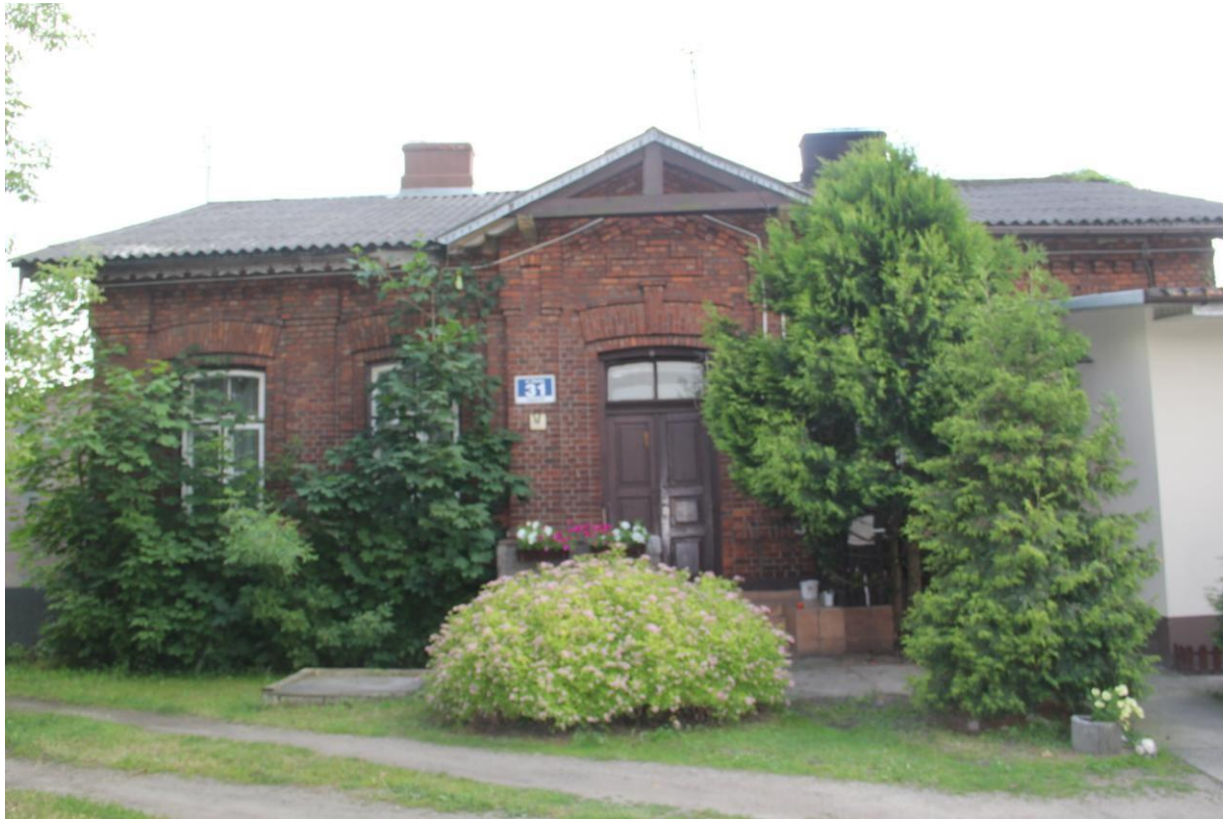
Elewacja od ul. Szkolnej
