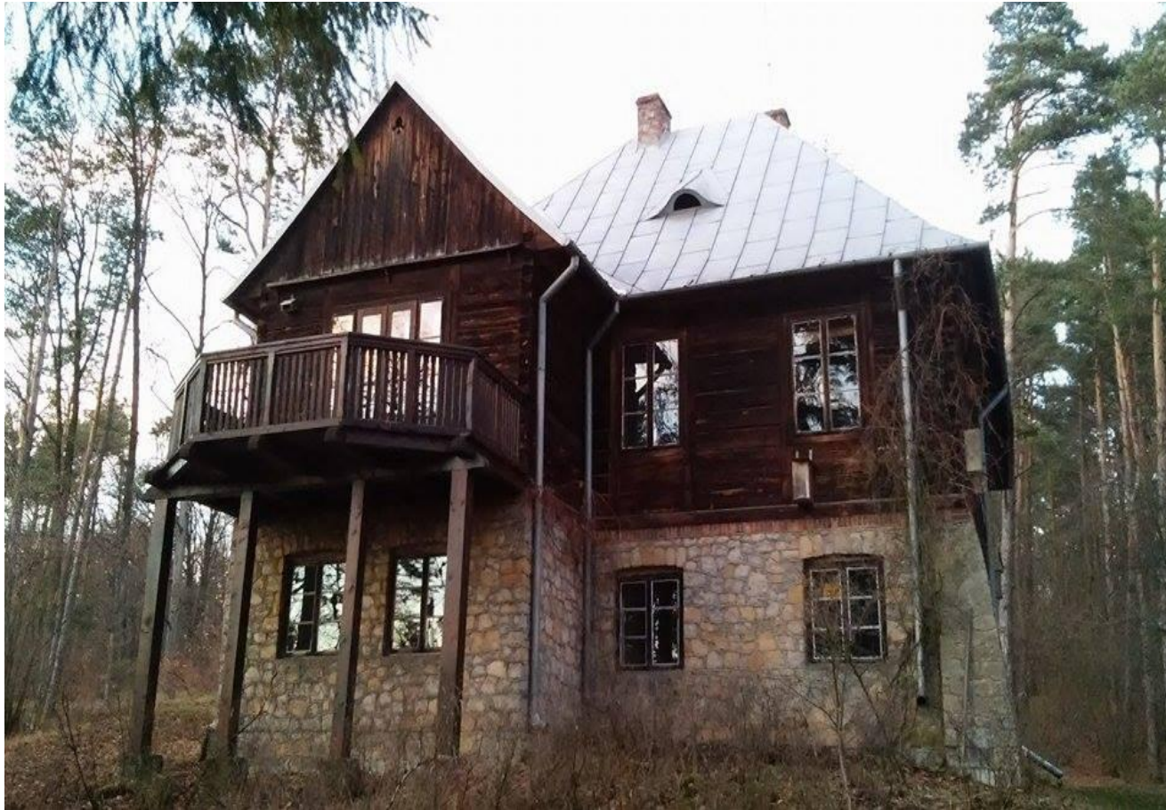
Widok od strony pld.
