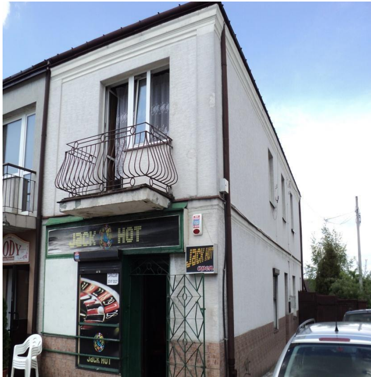
Elewacja płd. Od Pl. 2 Czerwca
