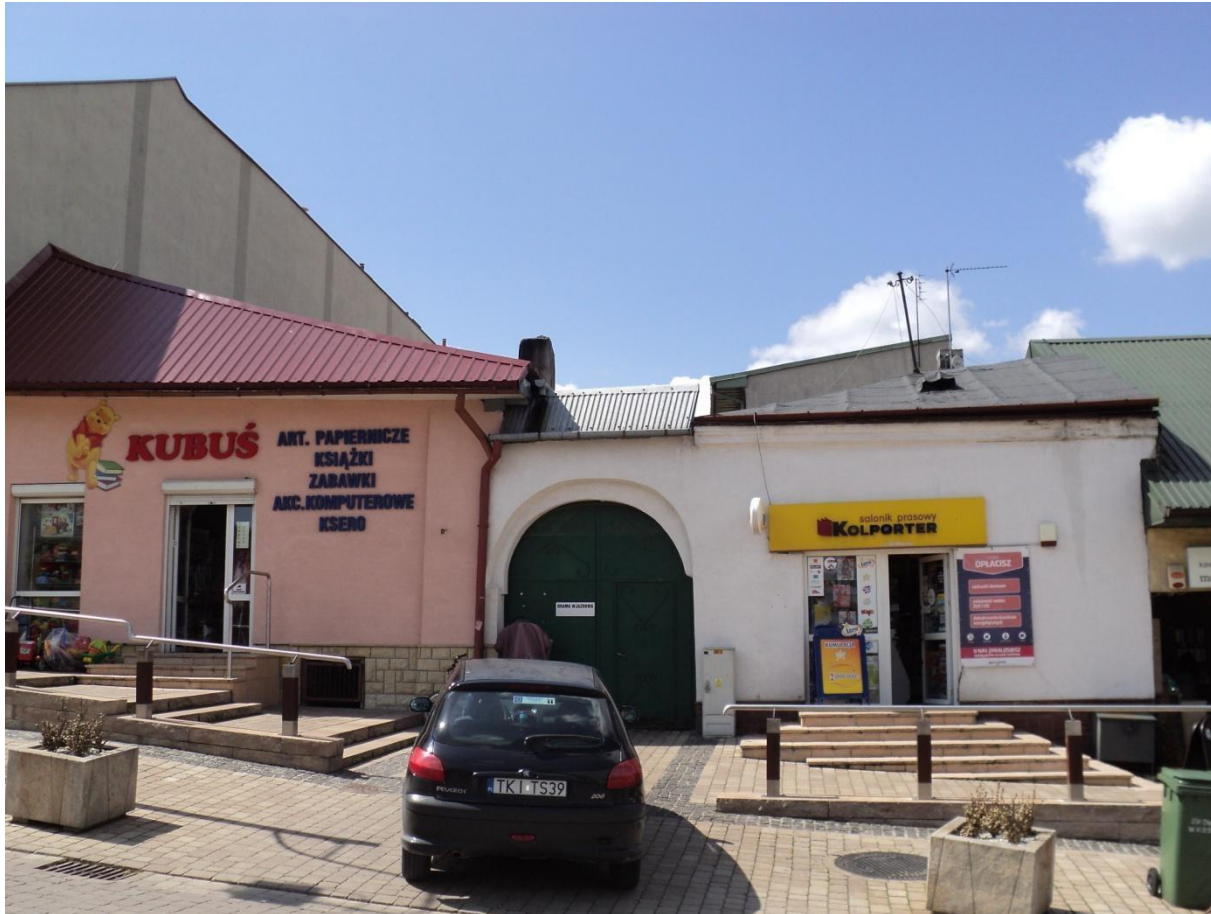
Elewacja wsch. od Pl. 2 Czerwca
