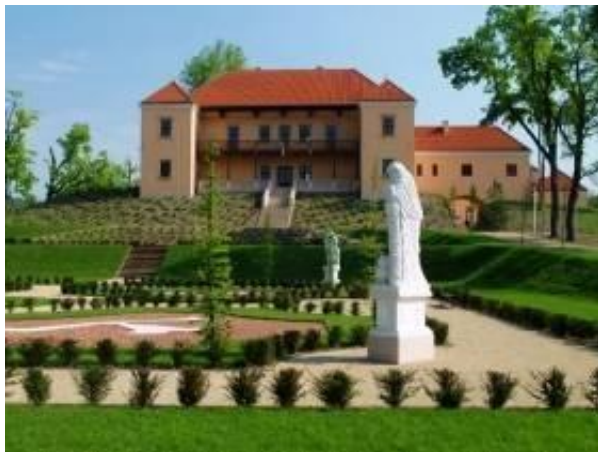
Widok od strony płd.
