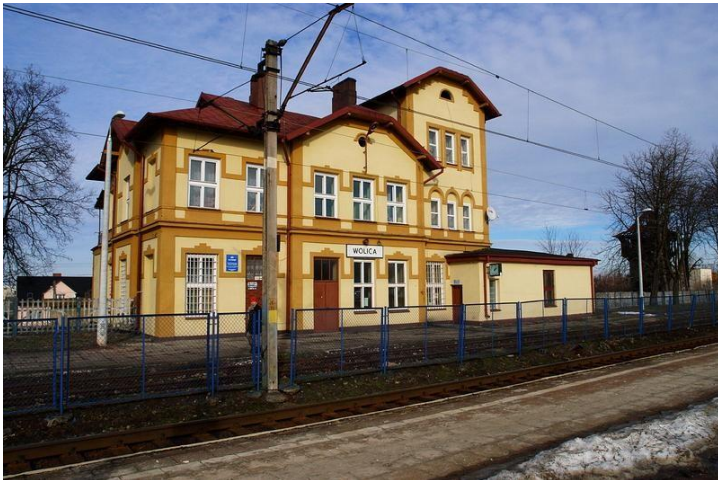
Elewacja od strony peronów
