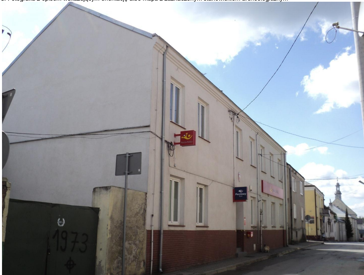
Elewacja od ul. Małogoskiej
