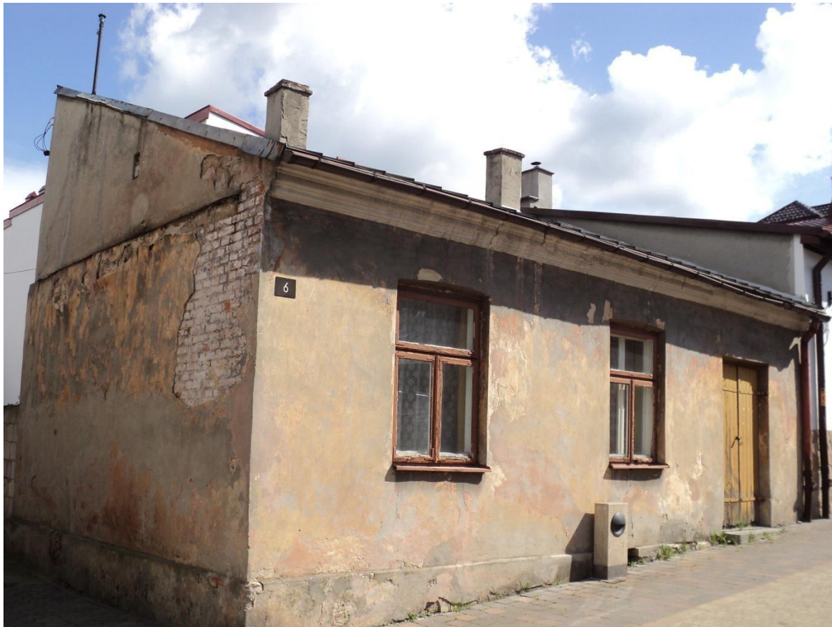
Elewacja od strony ul. Łokietka
