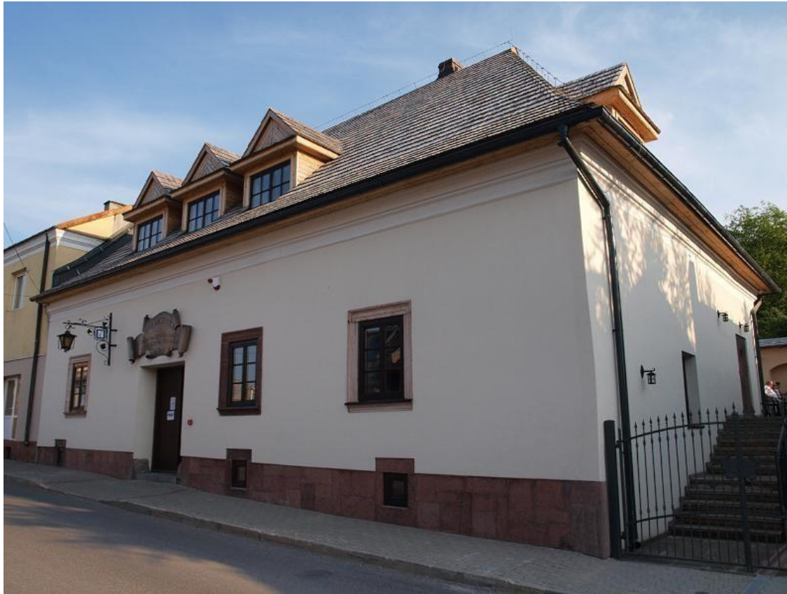
Elewacja północna od ul. Małogoskiej, wejście do budynku
