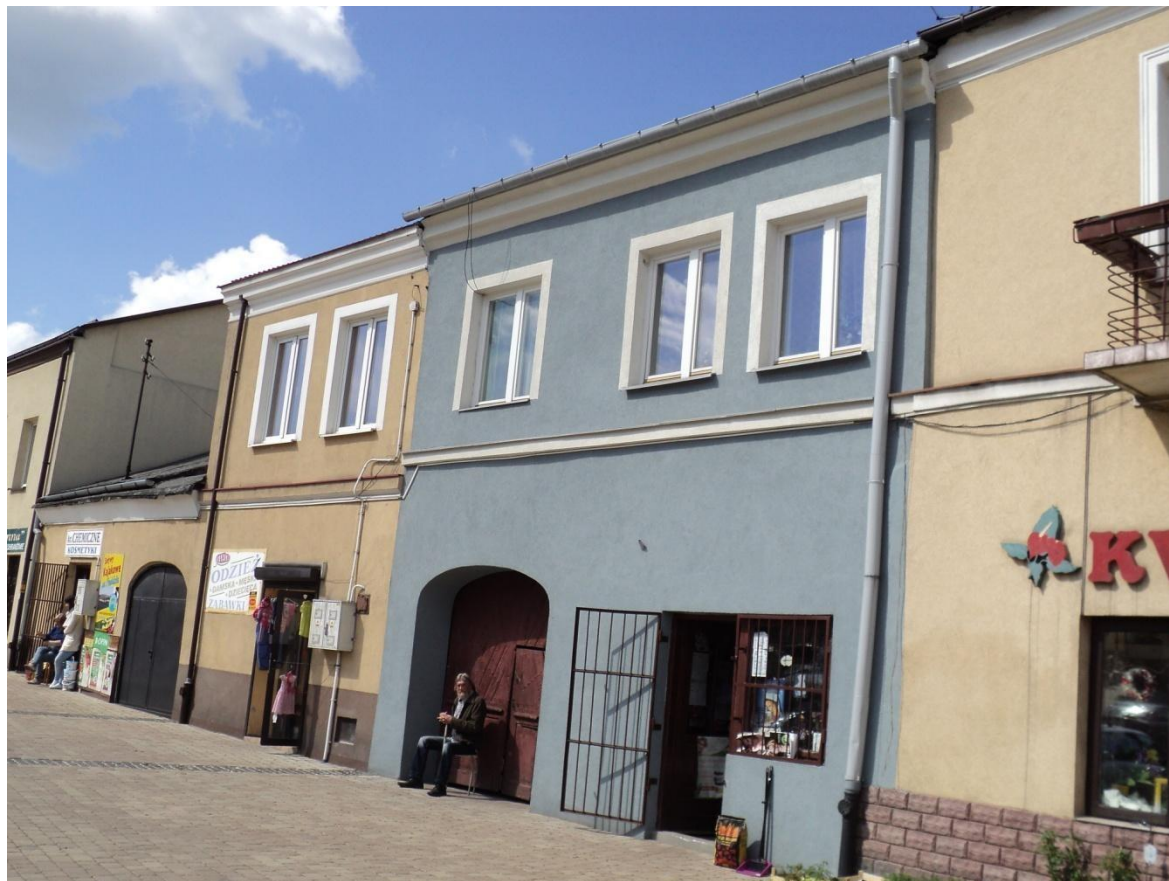
Elewacja płd., od Pl. 2 Czerwca
