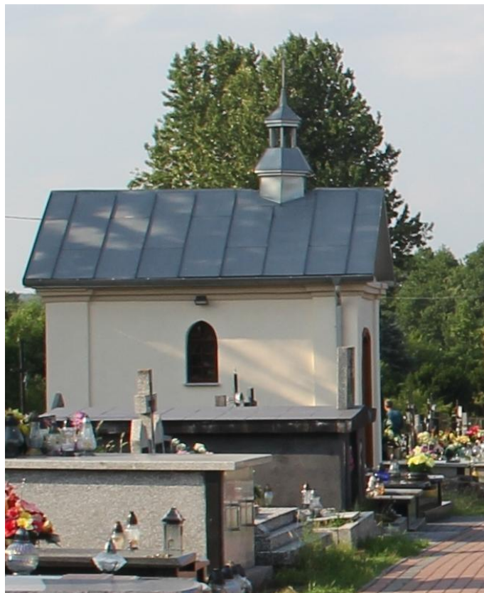
Widok od strony wejścia na cmentarz
