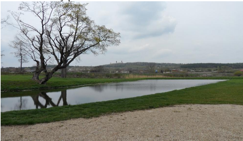
Widok od strony pld.-wsch.
