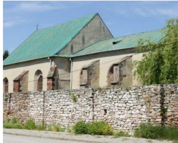
Widok od strony płd.
