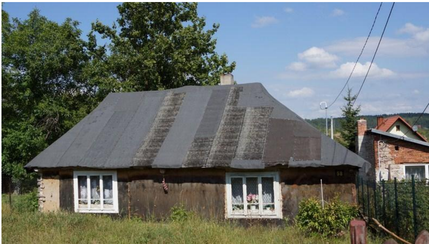
Elewacja od ul. Małogoskiej
