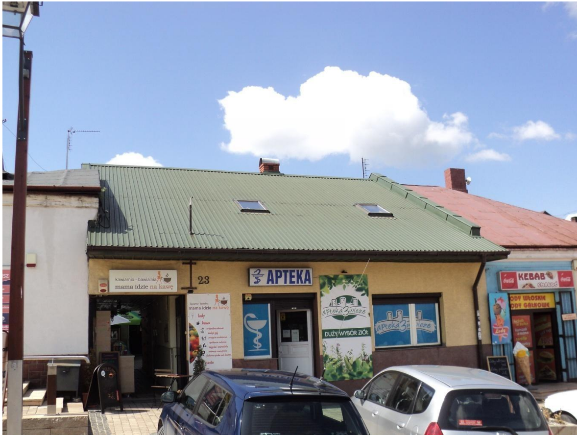
Elewacja wsch. od Pl. 2 Czerwca
