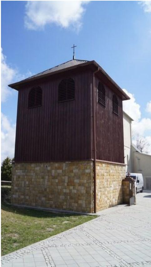
Elewacja od drogi głównej w Bolminie, widok od strony cmentarza parafialnego
