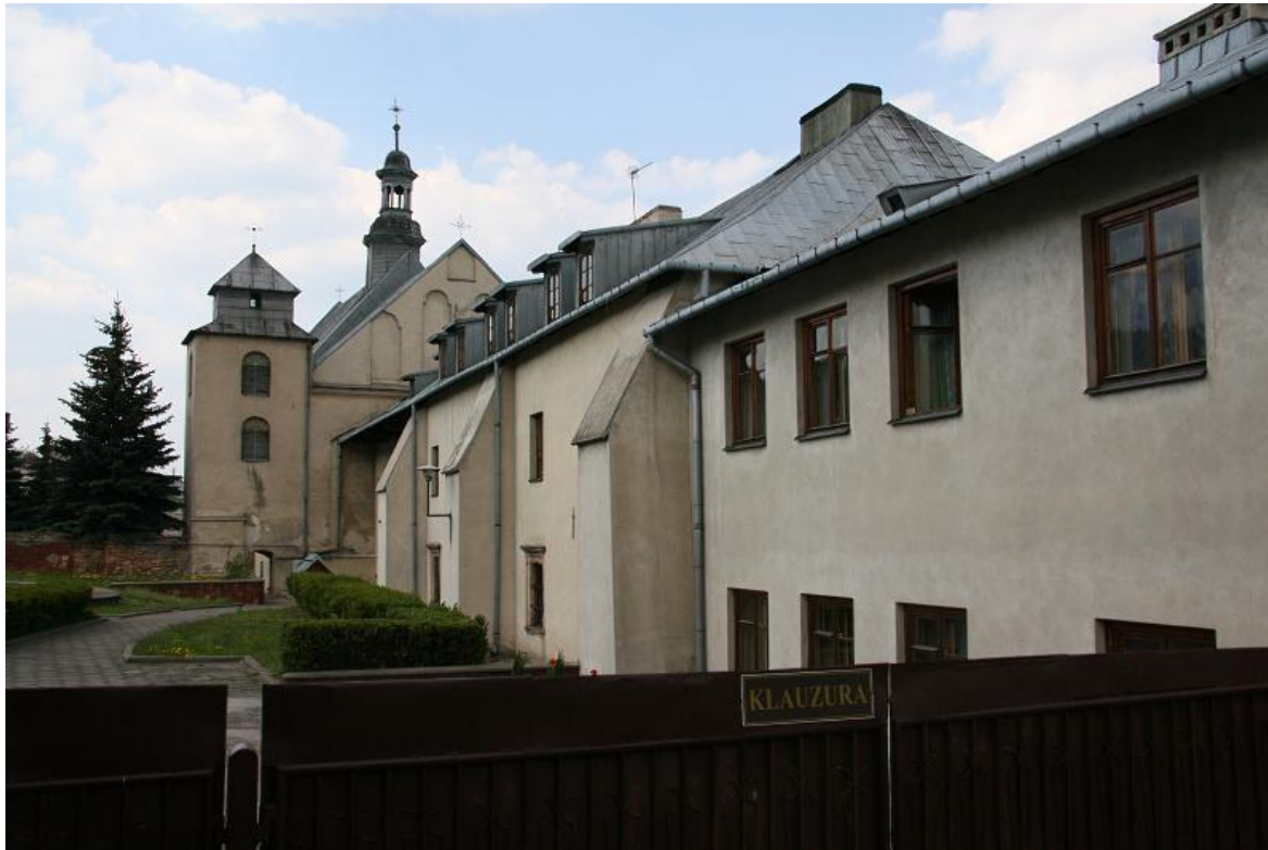
Widok na teren klasztorny od strony bramy wjazdowej/ul. Małogoska
