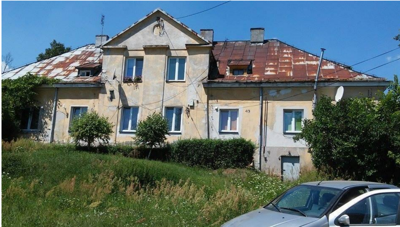
Widok od strony wsch., drogi krajowej E77
