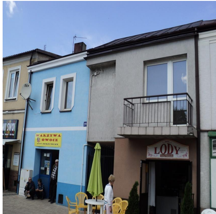
Elewacja płd. Od Pl. 2 Czerwca
