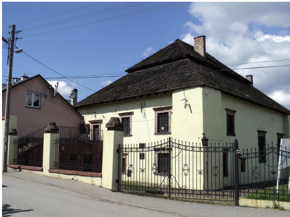
Widok od strony ul. Długiej
