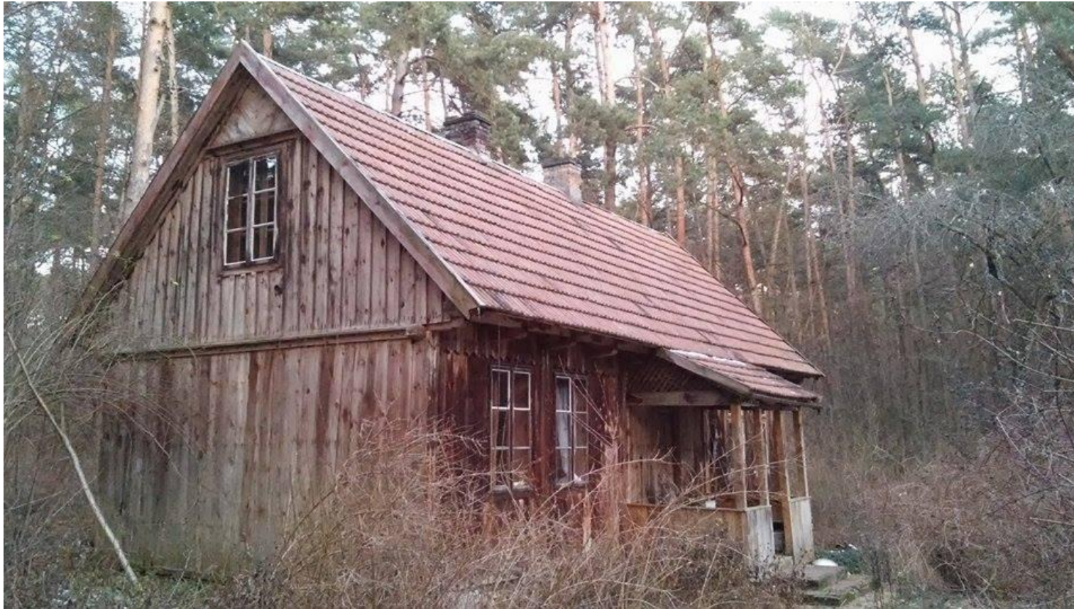
Widok od strony ganku, drogi dojazdowej
