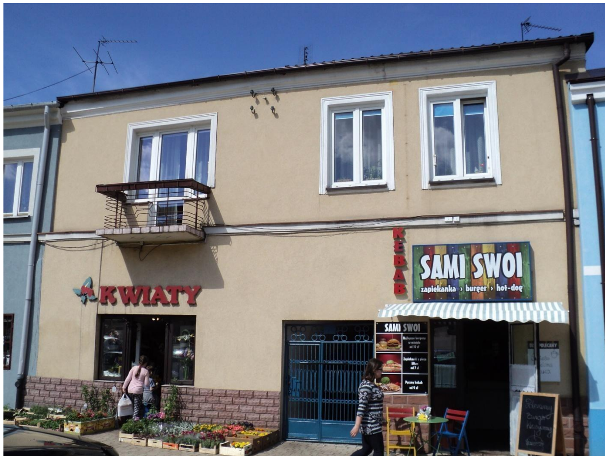
Elewacja płd., od Pl. 2 Czerwca
