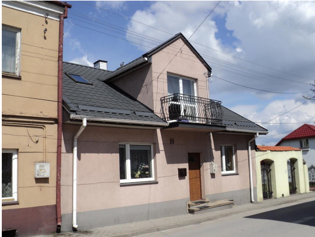
Widok od strony pld., ul. Długiej
