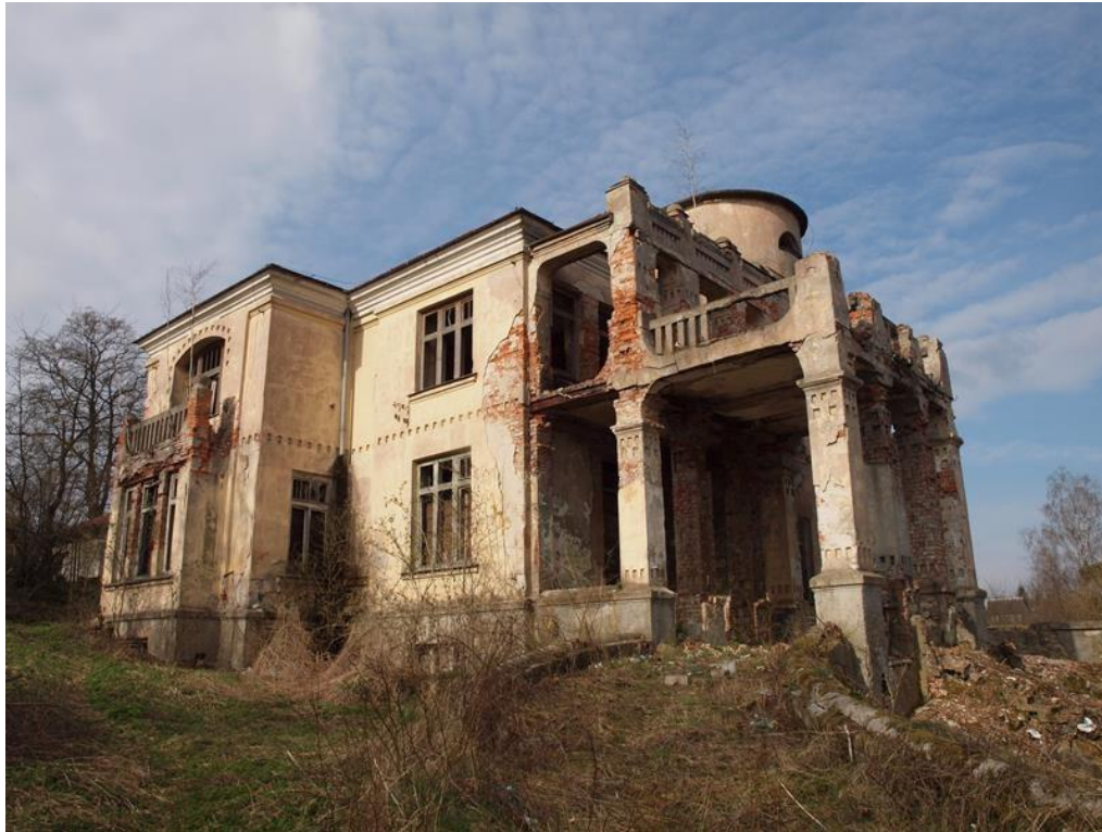
Widok od strony płd.
