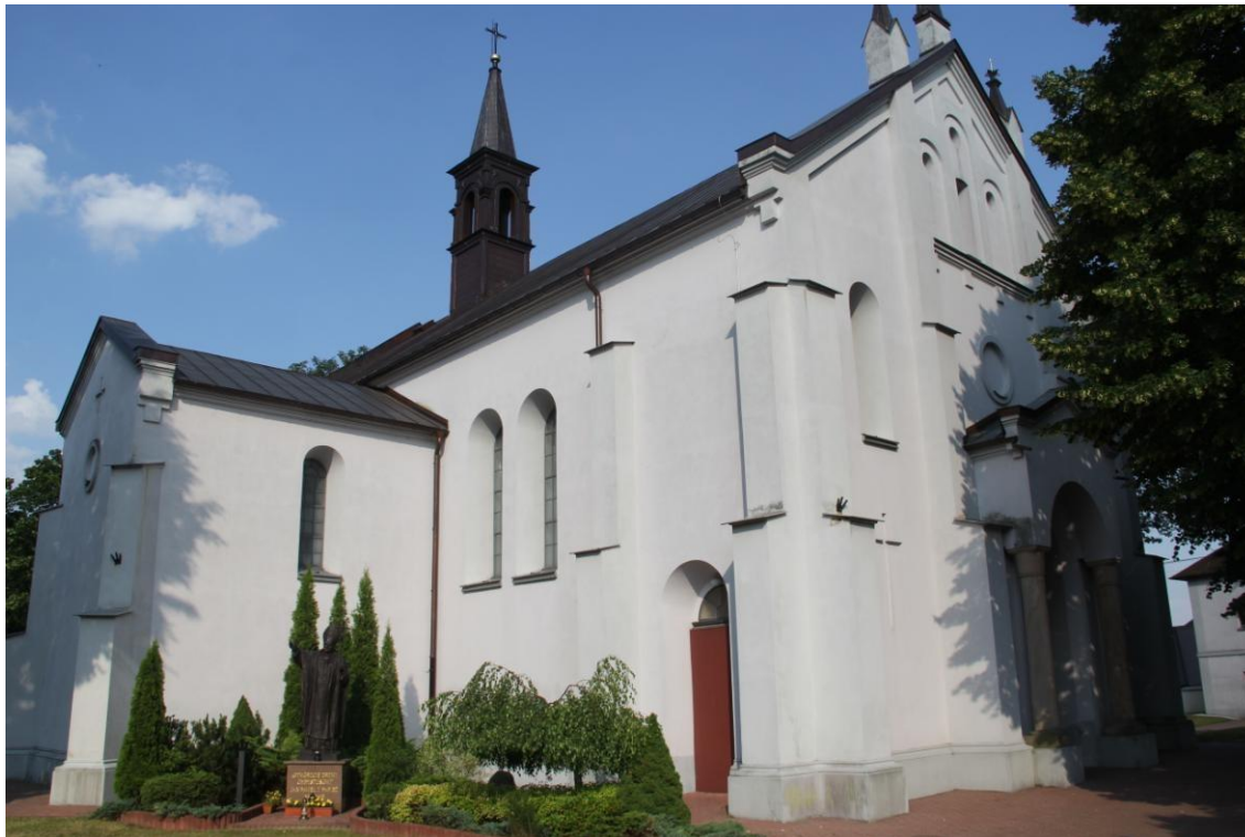
Widok od strony drogi powiatowej
