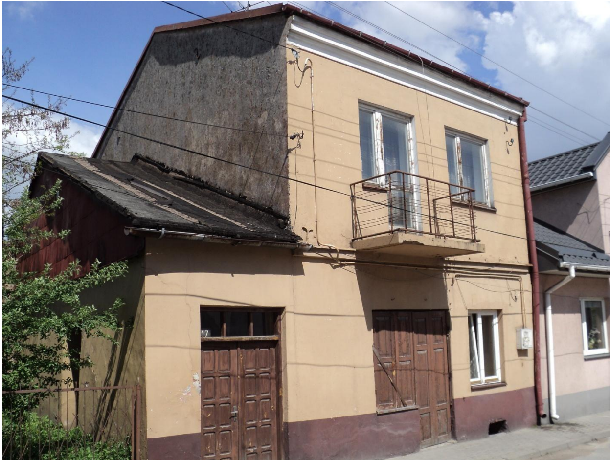
Elewacja od ul. Długiej
