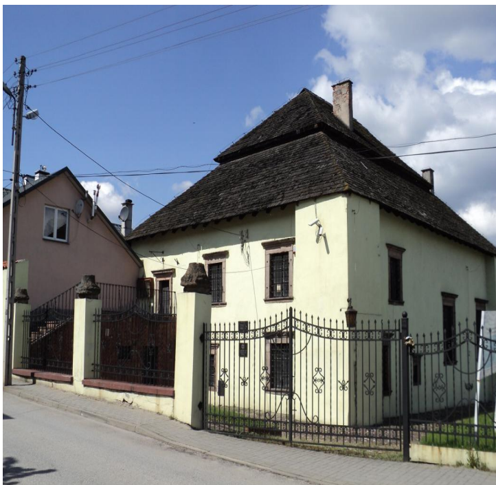
Widok od strony pld.
