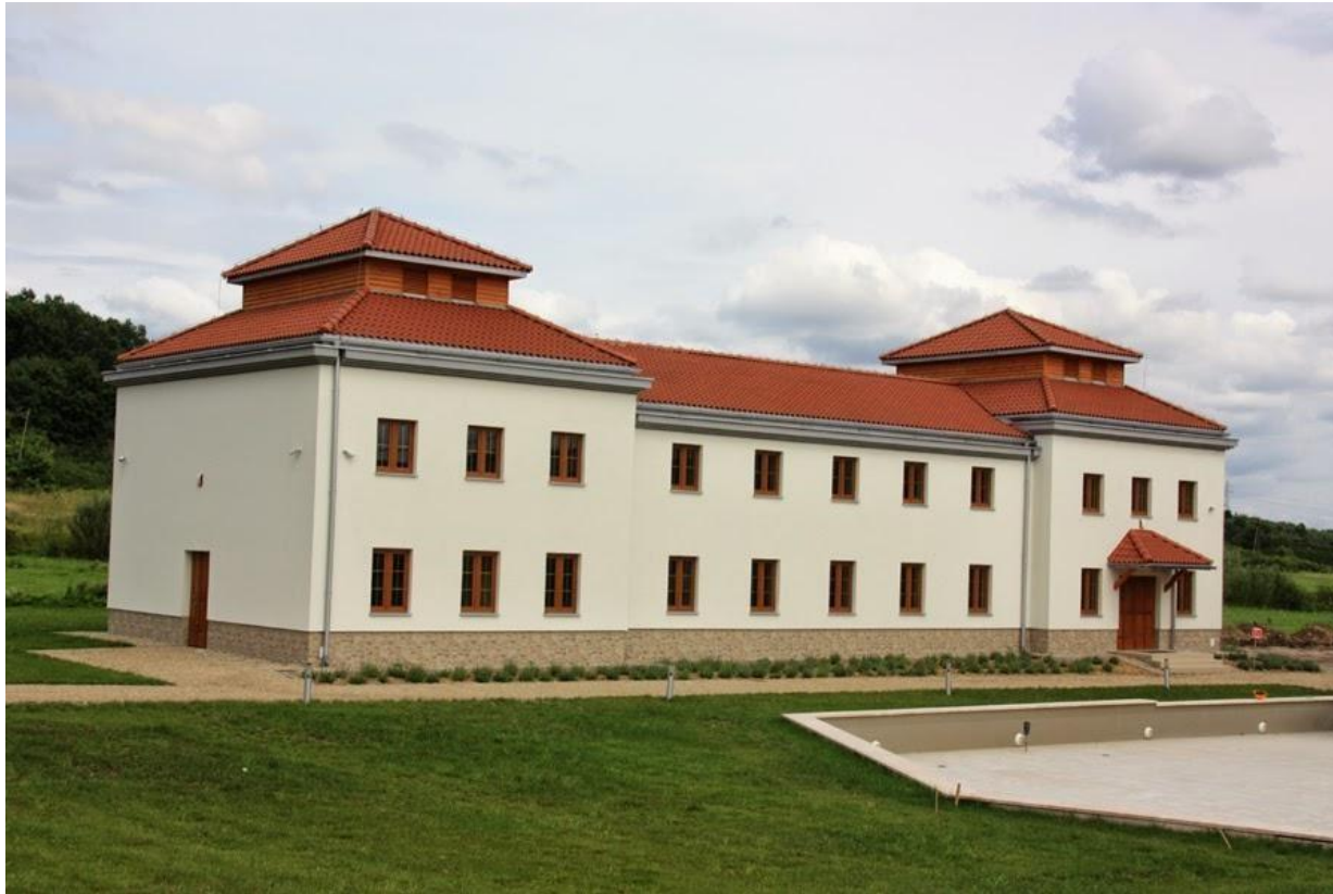
Widok od strony pld.
