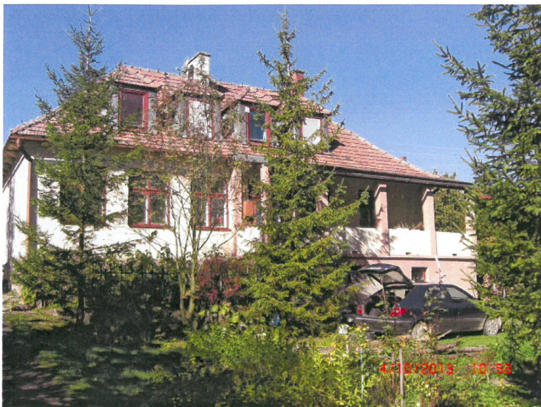
Fot.1 Elewacja wschodnia budynku na działce nr 127 w Zboiskach
