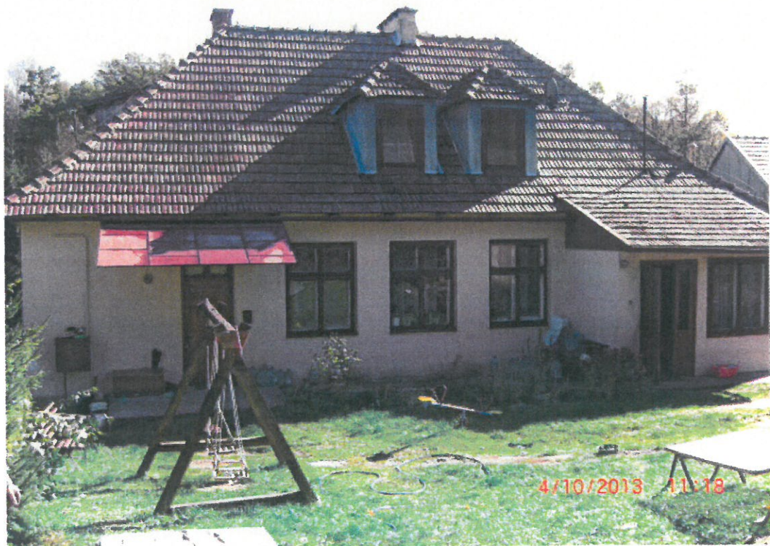
Fot. 2 Elewacja zachodnia budynku na działce nr 127 w Zboiskach
