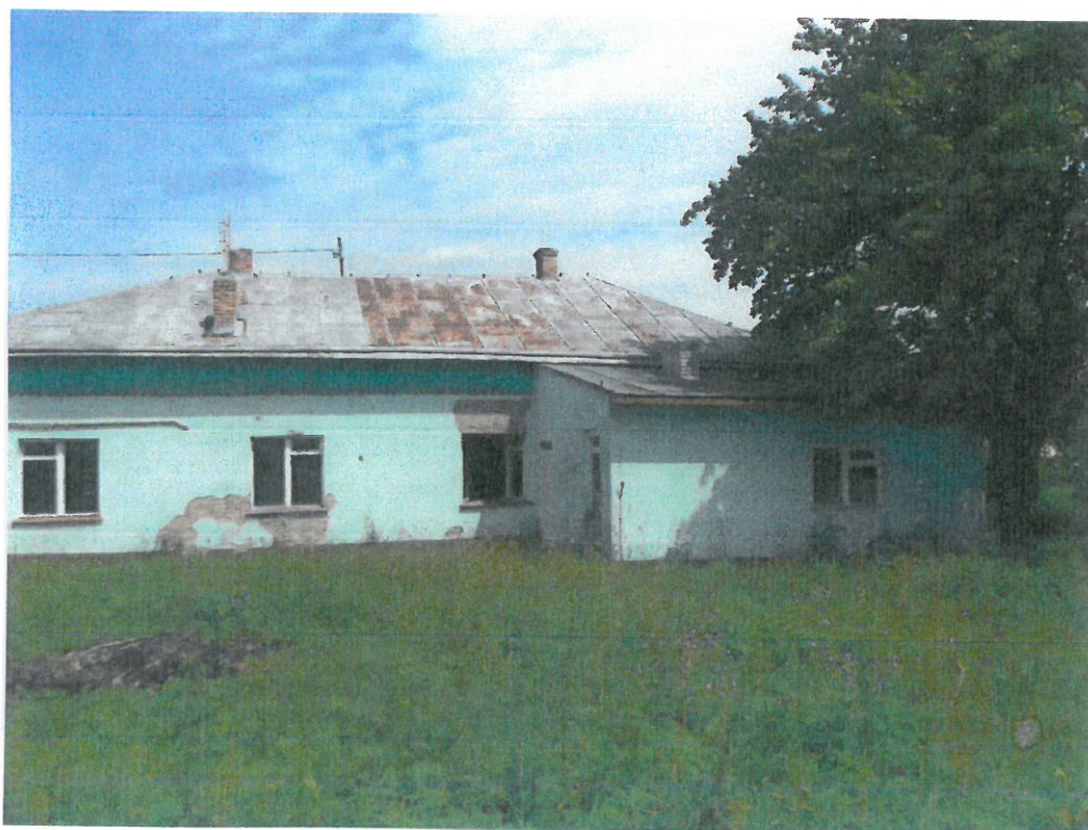
WIDOK OD STRONY ZACHODNIEJ
