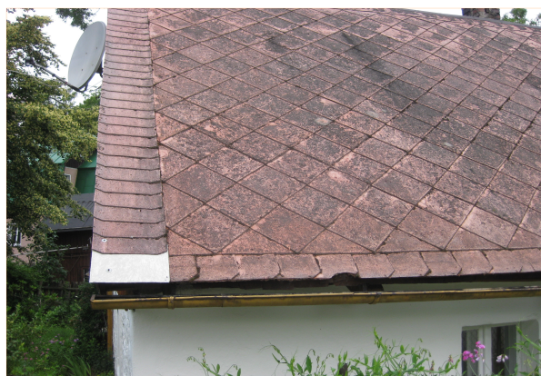
Fot. 2 Płyty azbestowo-cementowe płaskie
